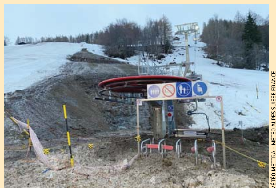
Ambiance pas du tout hivernale lundi, après plusieurs jours de douceur et de pluie jusqu'à haute altitude. De nombreuses avalanches de neige humide se sont produites. Visions tristounettes, comme cette vue d'une installation d'Eischoll dans le Haut-Valais, repérée sur le site Meteo Mettra. Les précipitations d'hier ont depuis changé la donne.
